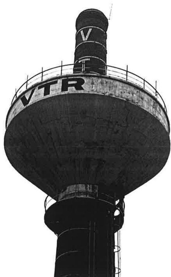
DETAIL DU RESERVOIR D'EAU ET DE LA PLATE-FORME
